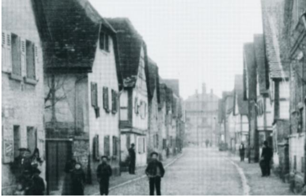
Torbau von der Schloßstraße
